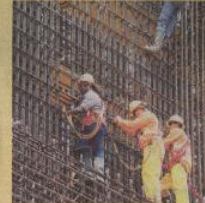
Yorlany Francis se la juega haciendo los trabajos de altura; ella rápidamente se acomodó con el arnés.
